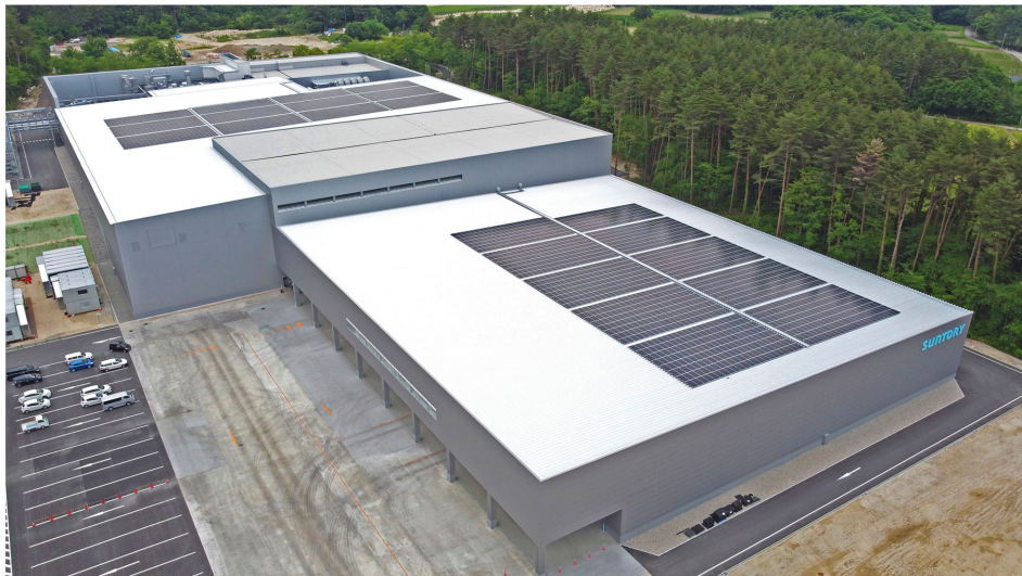
「サントリー天然水 北アルプス信濃の森工場」
