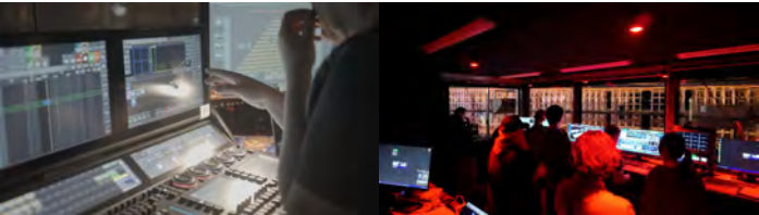
建屋に設置されたECA2のオペレーションルーム。ここでショー全体の制御が行われていた。
