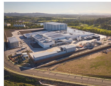
オーストラリア・クィーンズランド州の新工場「Swanbank Beverage Facility（スワンバンク工場）」。オセアニアにおける生産の中核を担うとともに、物流拠点としても活用されます。
