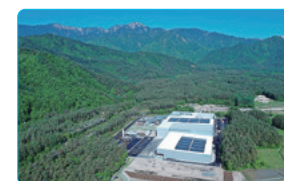
「サントリー天然水 北アルプス 信濃の森工場」稼働
