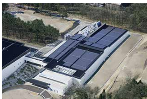
サントリープロダクツ（株） 天然水 南アルプス白州工場
