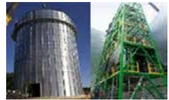
実証プラント
