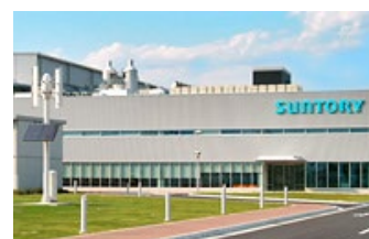
雨水を植栽の散水に活用している サントリープロダクツ (株) 神奈川綾瀬工場
