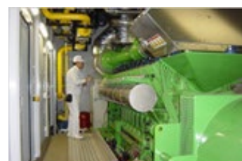
利根川ビール工場の コジェネレーションシステム
