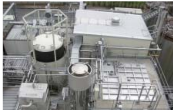
木曽川工場の嫌気性排水処理設備
